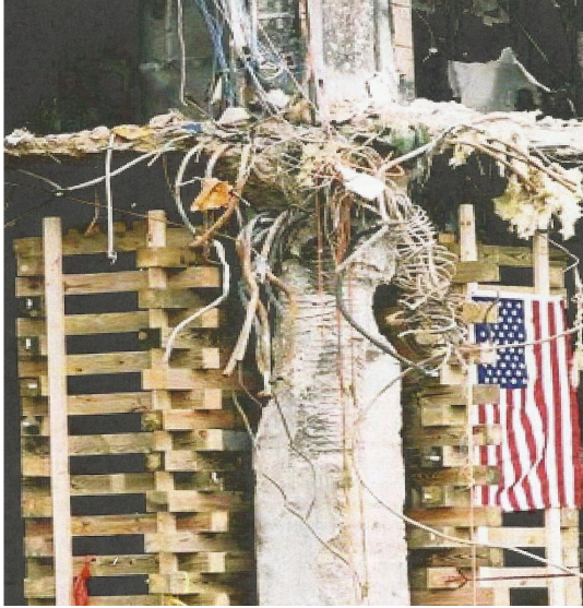
FIGURE 11.13 – Une colonne localement affaiblie par une charge annulaire ayant entamé le béton et soufflé la plus grande partie de l'armature métallique
